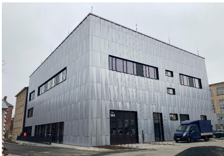
Ansicht Forschungsgebäude IET
