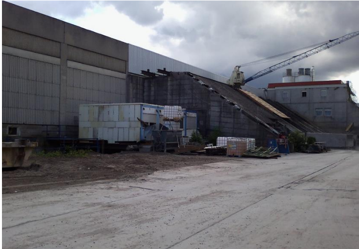
Ansicht Forschungsgebäude IET
